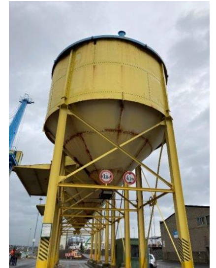
Umsetzung am realen Silo
